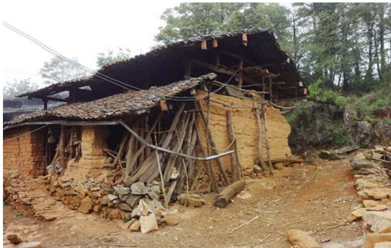
這房子有半邊極大損壞，由於村子遠在山上沒有車路運輸建築材料，採用 SuperAdobe 土袋房屋建築方法，用袋子及地上泥土建成。
